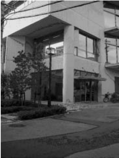
写真—4 大阪研究室のある産総関西センターの中の光機能材料研究棟
