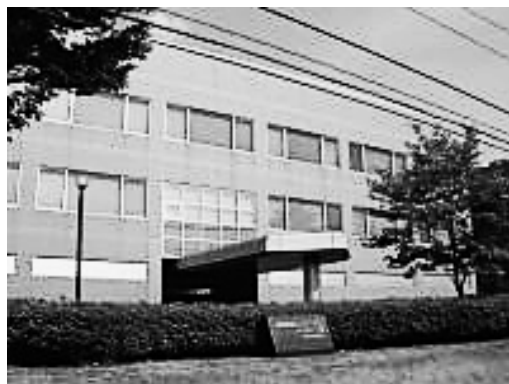
写真 1 パイロット棟外観
