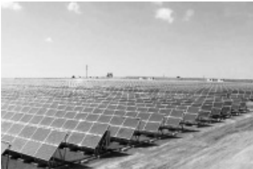
写真 3 スペイン Olmedilla 太陽光発電所の全景 (60 MW) 提供 (株) 資源総合システム
