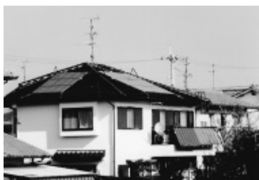
写真2 初の実生活逆潮流ありの個人住宅用太陽光発電システム
