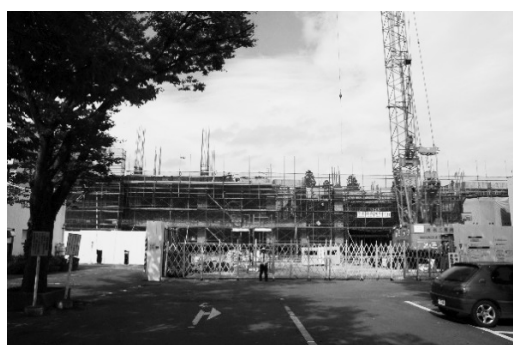
写真2 建築中の新研究棟
