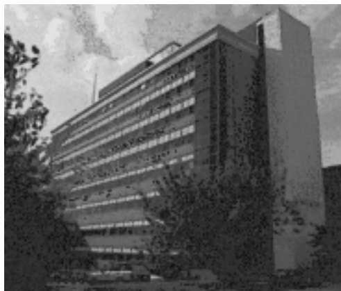
図1 シェフィールド大学物理学科 (Hicks Building)
