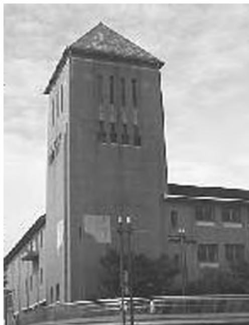
写真：日時計の時計台「光の塔」。
