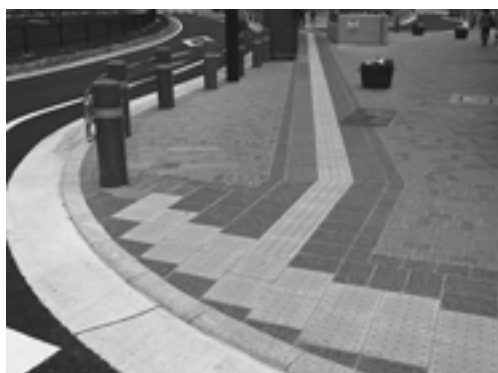
写真3 カレット入りインターロッキングブロック 施工例
