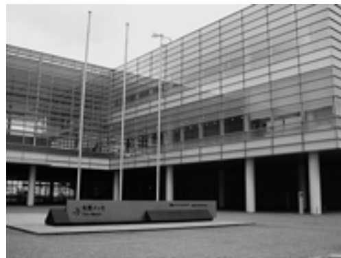
写真1 新潟コンベンションセンター“朱鷺メッセ”
