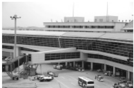
図 9 防汚ガラス施工例（セントレア空港）
