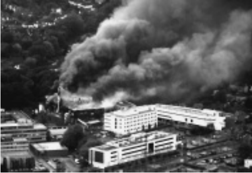
写真 4 ORC クリーンルーム爆発火災事故写真
